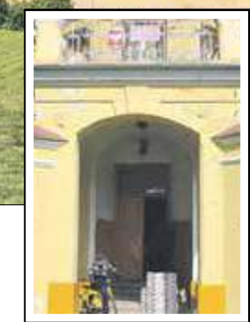
Pałacyk w Branicy już kilkadziesiąt lat służy celom edukacyjnym
