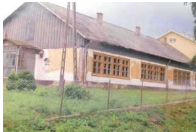
Po drewnianym budynku szkoły nie ma już śladu. W tle widoczna już nowa szkoła. Widok od strony wschodniej.
