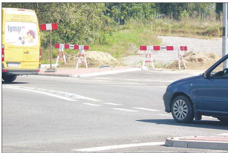
Obecnie wjazdu z ronda na budowany łącznik bronią zapory drogowe.
