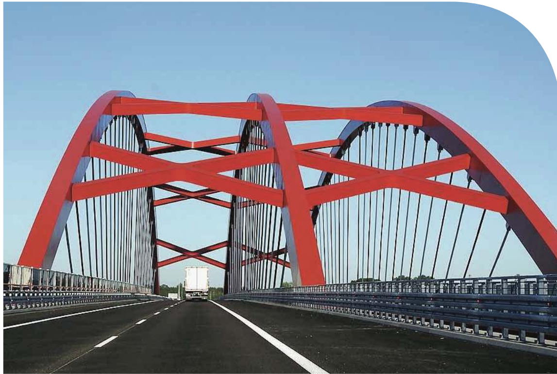
Coraz lepsze drogi przyciągają na Warmię i Mazury także nowych inwestorów.
