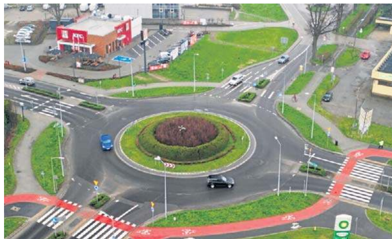
Obwodnica powstanie w ramach rządowego projektu 100 obwodnic
