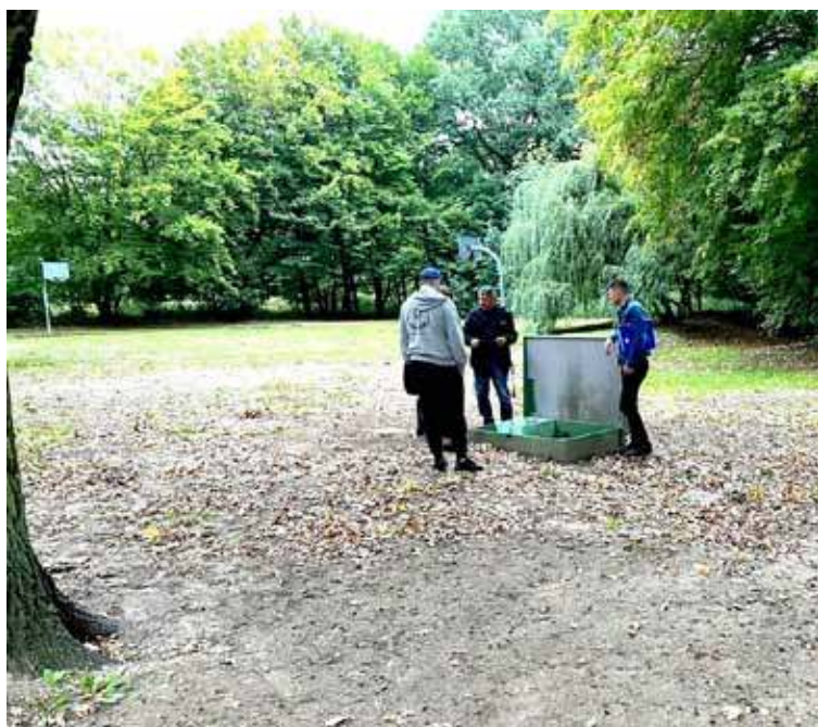
W Chlebówku przy szkole podstawowej zakończono budowę biologicznej oczyszczalni ścieków
