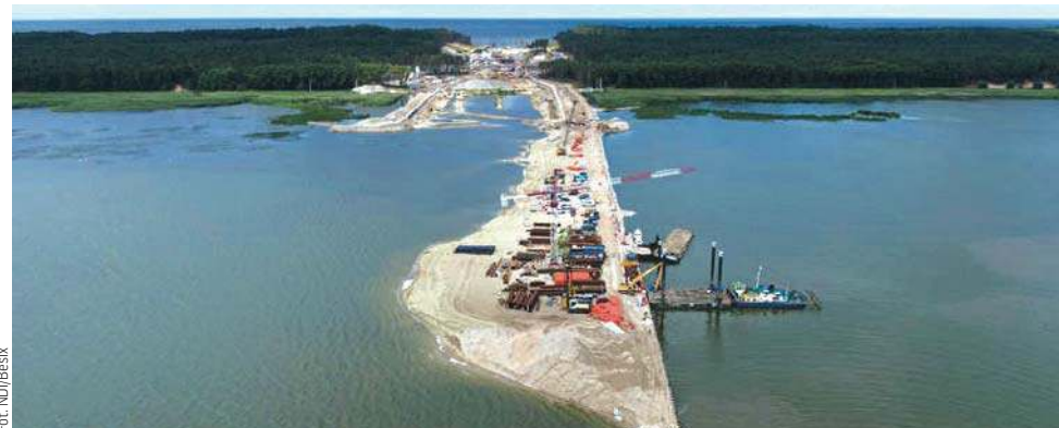
Sierpień — na terenie budowy praca nieustannie wre
