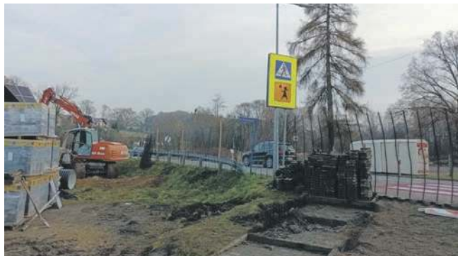
Budowa chodnika w Porębie Żegoty
