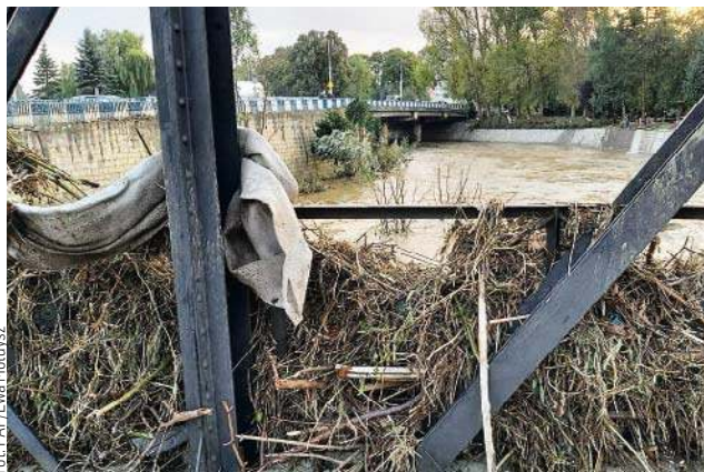
Zniszczenia po powodzi w Kłodzku
