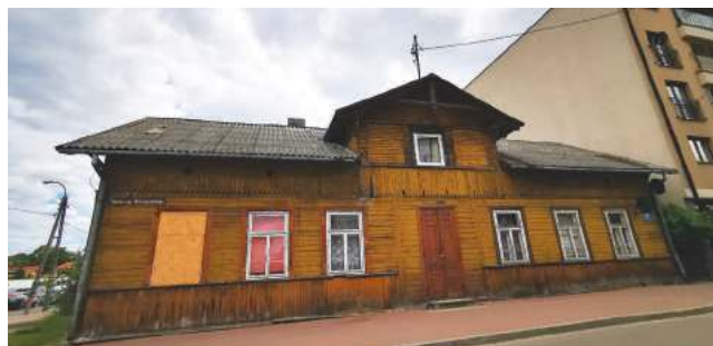
Jeden z budynków komunalnych przy ul. Daszyńskiego, obecnie już niezamieszkały. Czy zostanie przeznaczony do rozbiórki?
