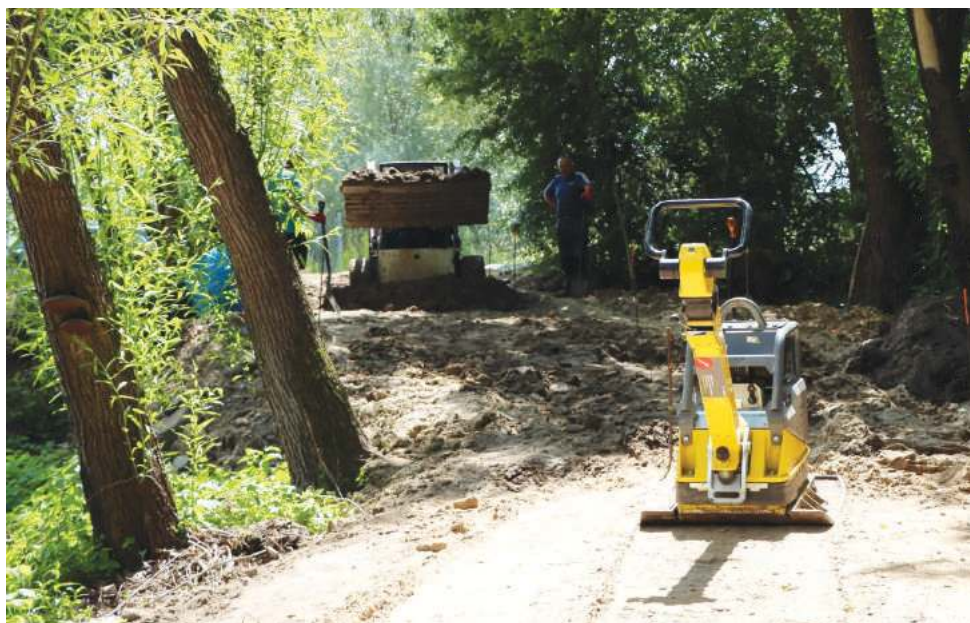
Trwają prace przy ul. Nadrzecznej
