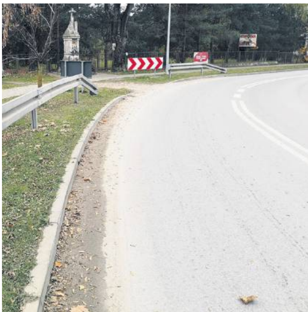
W miejscu, gdzie we wrześniu doszło do wypadku, zamontowana została metalowa barierka. Fot. Fb
