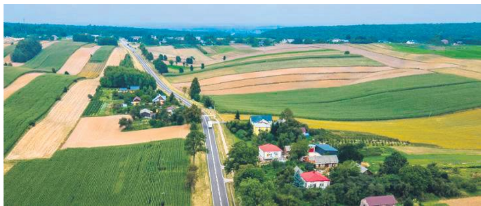
Odcinek od węzła Zamość Południe do węzła Tomaszów Lubelski Północ będzie liczył ok. 18,5 km i przebiegać będzie wzdłuż obecnej drogi krajowej nr 17 po jej wschodniej stronie.
