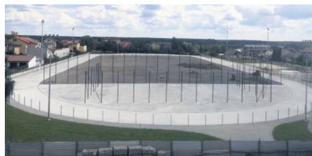
Nowoczesny obiekt sportowy powstaje przy ZSBiO w Biłgoraju.
