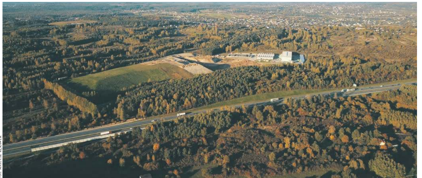
Składowisko odpadów w Balinie
