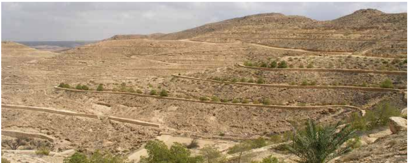
Przeciwoerozyjna zabudowa stoku w okolicach Matmaty w Tunezji
