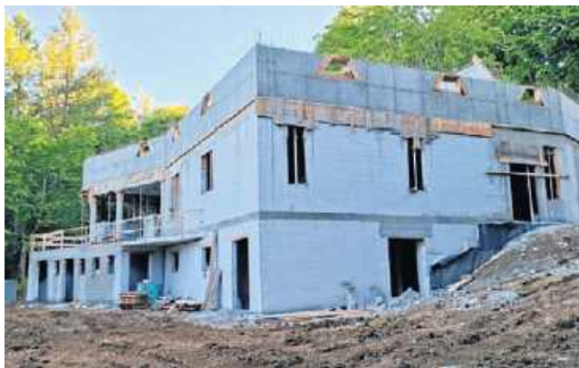
Budowa nowego schroniska na Magurze Małastowskiej
