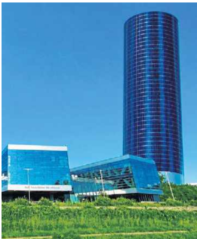
Wizualizacja inwestora - magazyn energii, niczym komin, ma wpisać się w otoczenie Miasteczka Multimedialnego. Jego ściany pokryte są panelami fotowoltaicznymi
