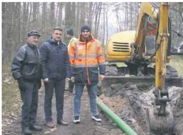
Reinhard Schygulla (z lewej) podczas budowy kanalizacji. Inwestycję oglądał codziennie przez dwa lata, a w sumie poświęcił jej 5 lat życia
