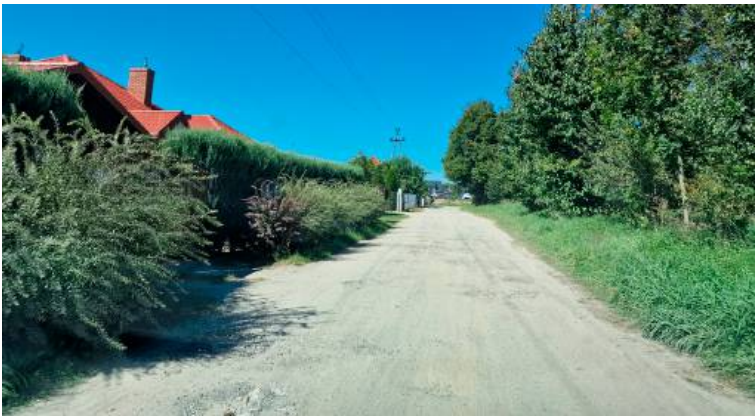
Gruntowa dziś ulica Dywizjonu 303 w niedalekiej przyszłości ma połączyć al. Lotników Polskich z budowaną właśnie ul. DREWNIANĄ
