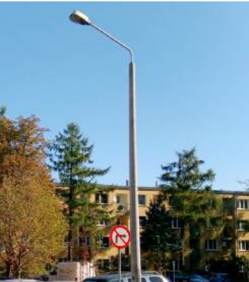
Wymieniona latarnia przy ul. Puławskiej
