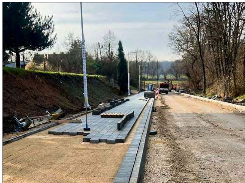
Przebudowa drogi powiatowej 1408 O ulica Solownia wraz z oświetleniem w miejscowości Zdzeszowice.
