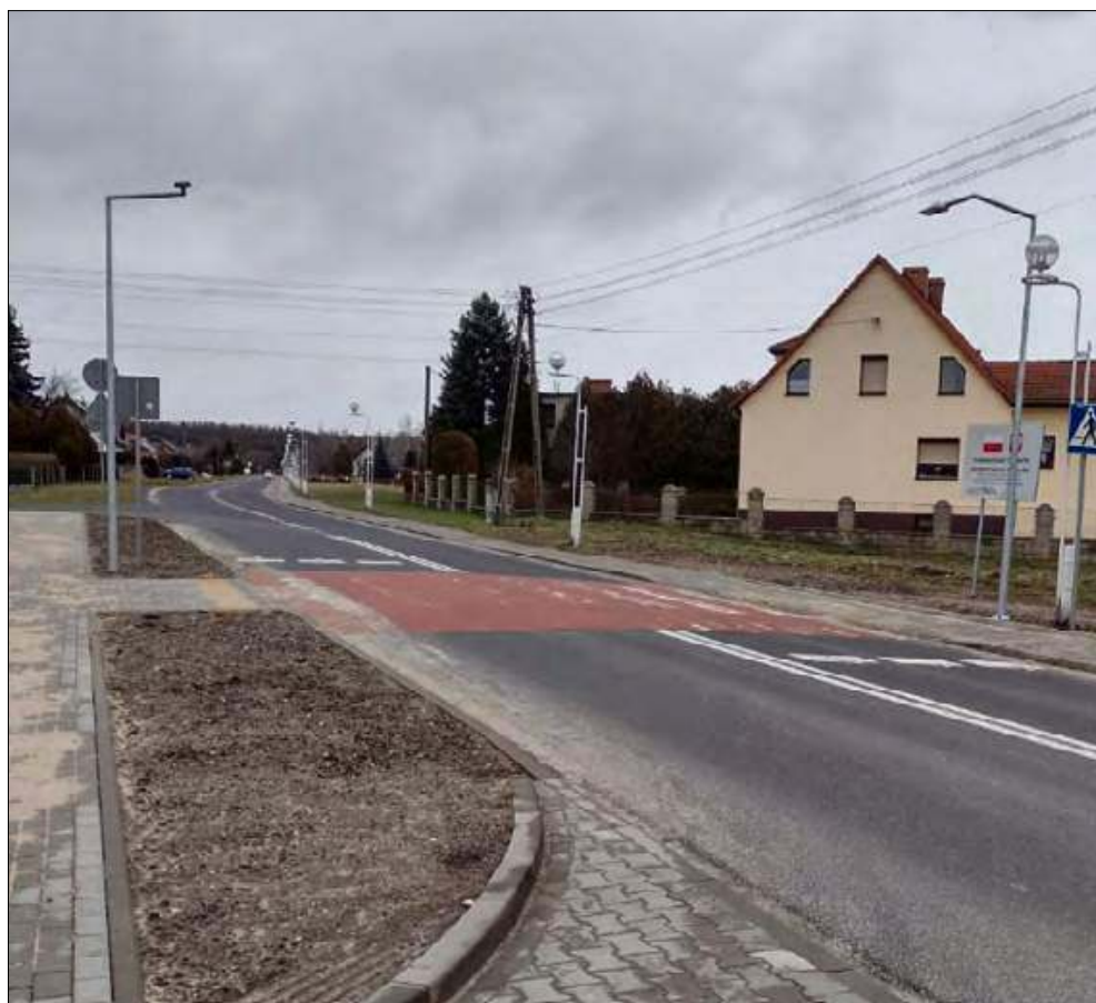
Budowa przejścia dla pieszych w ciągu drogi powiatowej nr 1808 O ul. Góra Św. Anny. Poprawa bezpieczeństwa przy sklepie Dino.
