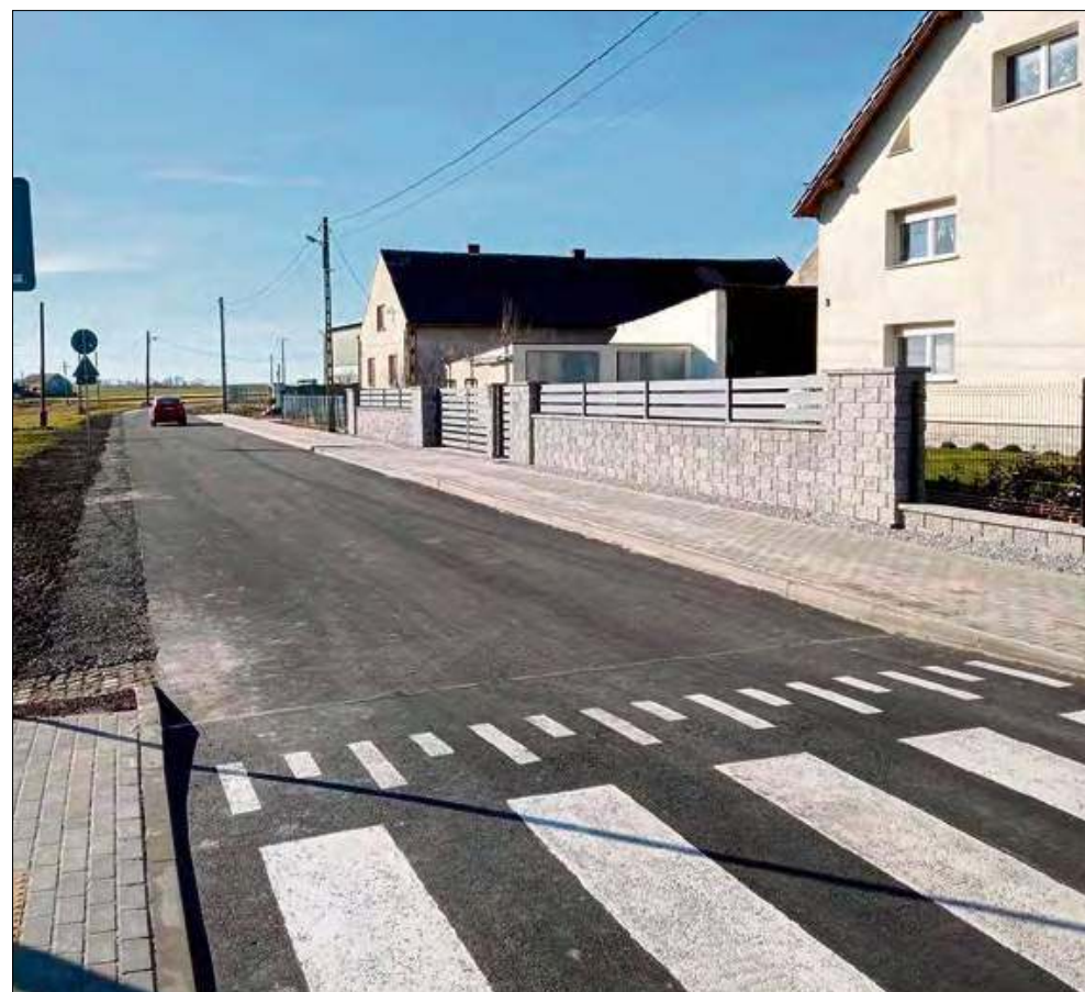
Przebudowa drogi powiatowej nr 1445 O w zakresie budowy chodnika w miejscowości Ćwiercie.
