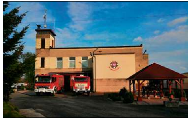
Remiza OSP będzie poddana termomodernizacji.
