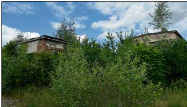
Była betoniarnia od lat szpeci centrum Gogolina.
