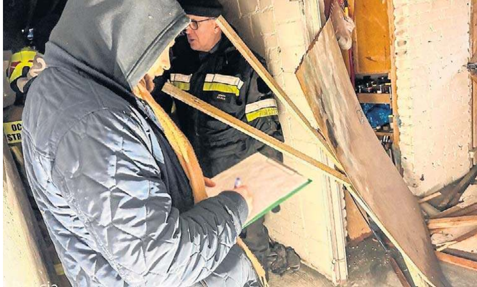
W bloku zostało uszkodzonych wiele piwnic, wejście do klatki oraz niektóre drzwi do mieszkań
