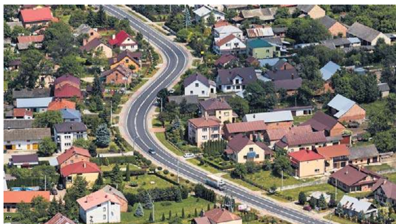
Nowa obwodnica przyczyni się do poprawy bezpieczeństwa oraz wyprowadzi ruch ciężkich pojazdów poza teren Przemyśla
