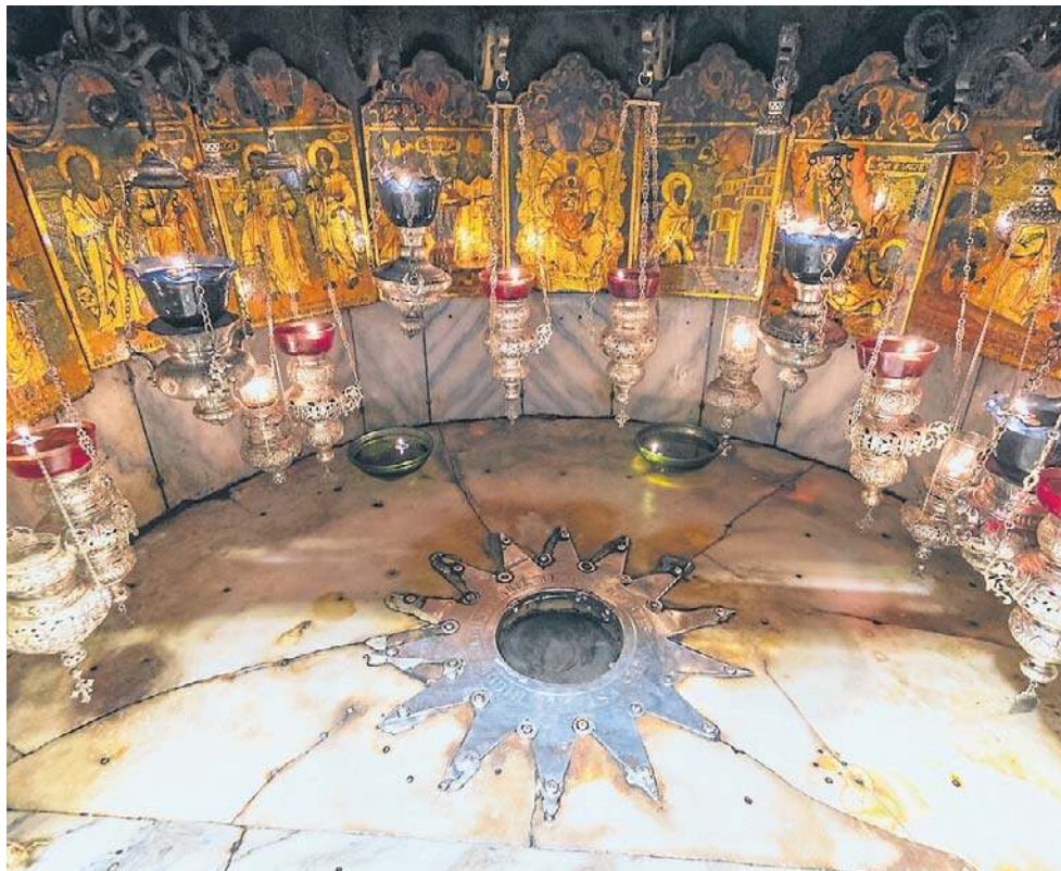
O tym, że zarówno bazylika, jak i grota wymagają remontu, poinformowali już w 2008 roku duchowni z Ziemi Świętej
