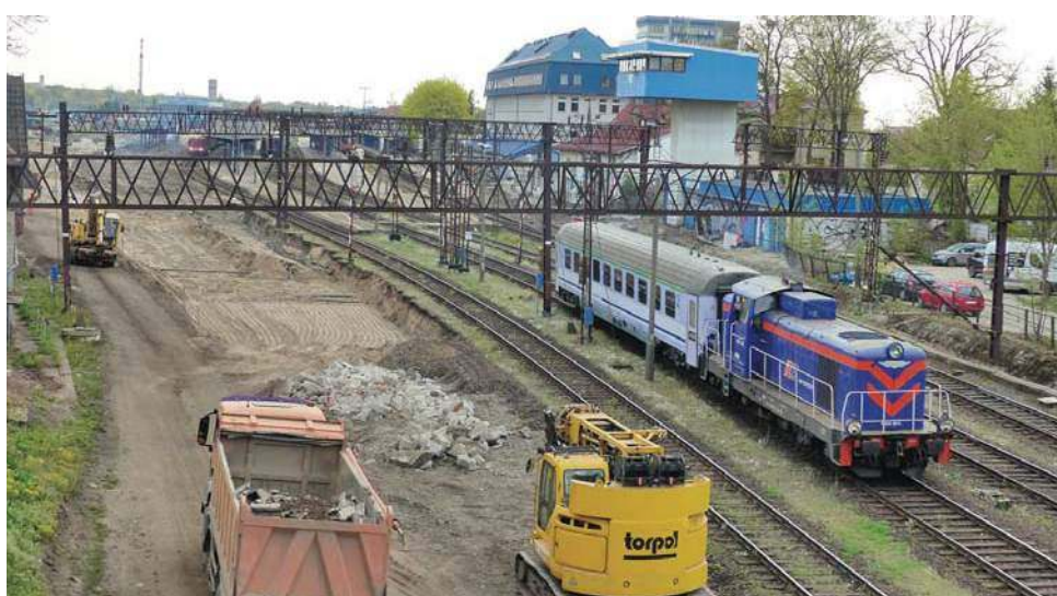
Na stacji zostało już zdementowanych ok. 20 km torów i sieci trakcyjnej
