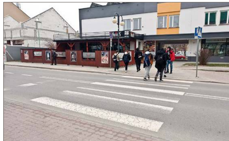
Przebudowa czeka m.in. przejście dla pieszych przy ul. Kościuszki.
