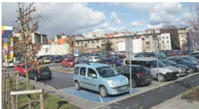
Budowa parkingu, bez urządzenia małej architektury i nasadzenia zieleni, kosztowała 1,1 mln zł
