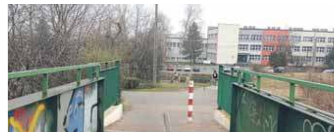
Kładka ma zostać przebudowana
