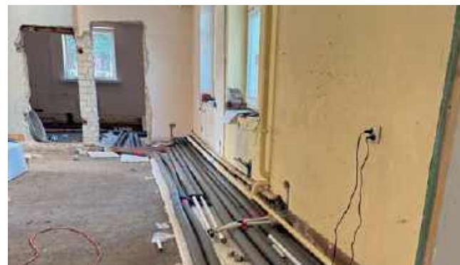
Prace na terenie PSP w Kończycach-Kolonii
