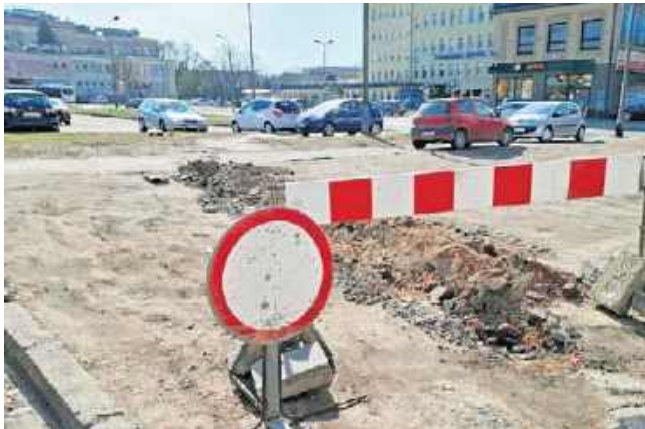
Od poniedziałku 16 marca wjazd na parking jest już utrudniony, zaczęły się roboty remontowe.
