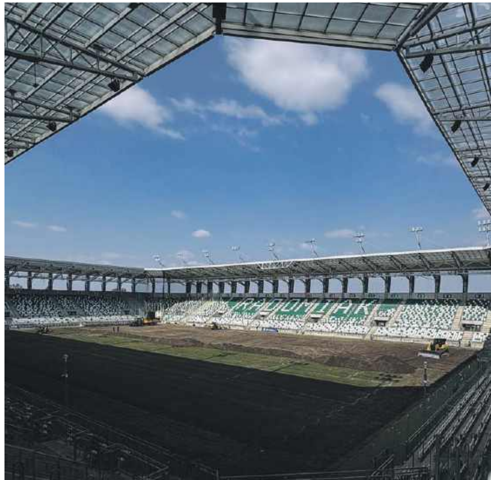
Tak w środę wyglądały prace na stadionie
