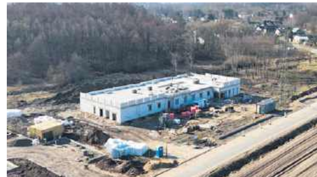
Postępy na budowie żłobka w Kosowie
