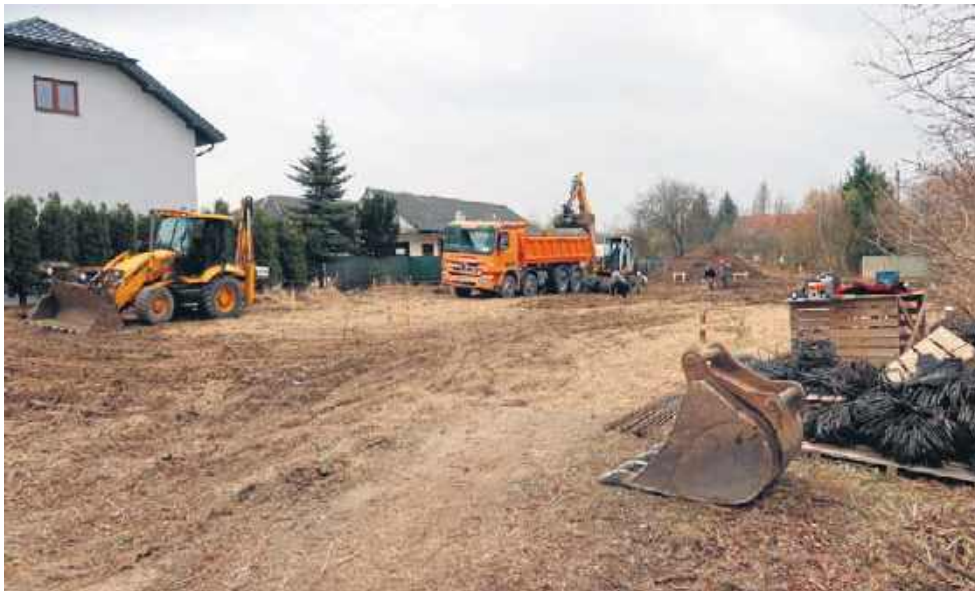
Zakończenie wszystkich prac zaplanowano na lipiec 2027 roku
