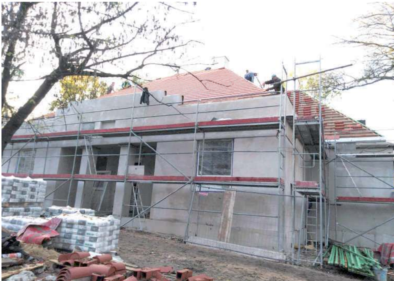
Remont Dworu Lachertów ma zostać ukończony w czerwcu przyszłego roku
