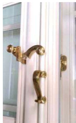
Okucia i klamki zrobione zostały na wzór pozyskanych przy demontażu zniszczonej kompletnie stolarki okiennej i drzwiowej
