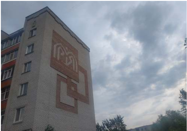
▲ Будинок у Северодонецьку. На стіні зображене слово «Мрія» — це назва місцевого житлового комплексу
