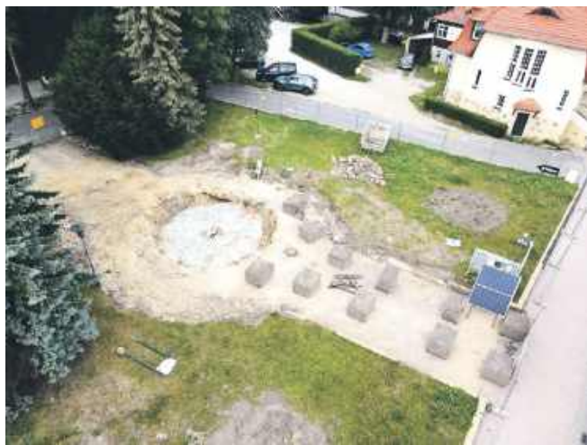
Zdjęcie wykonane zaraz po demontażu starej fontanny
