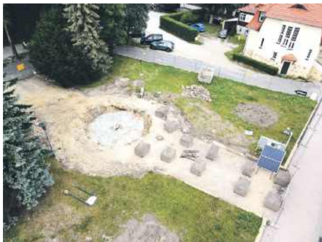
Zdjęcie wykonane zaraz po demontażu starej fontanny
