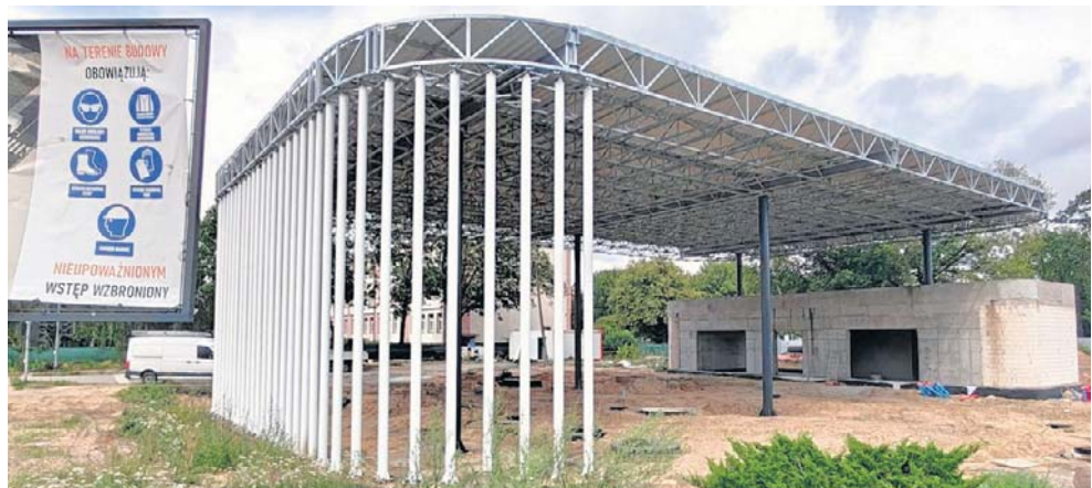
W Mątwach trwa modernizacja pętli autobusowej. Powstaje tam nowoczesny obiekt
