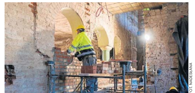
Prace wewnątrz pałacu w Nawrze
