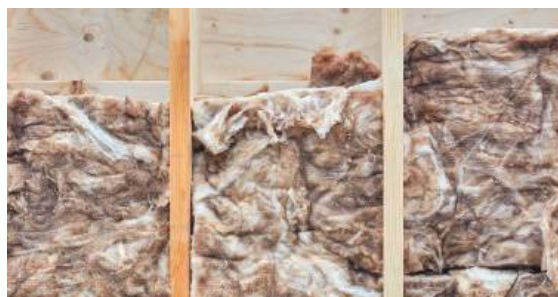
Izolacja ściany odpadową wełną owczą
