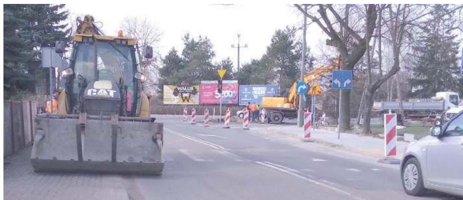
W marcu przyspieszyły prace na kilku białskich inwestycjach drogowych. Remont ul. Orzechowej trwa bez zamykania ruchu
