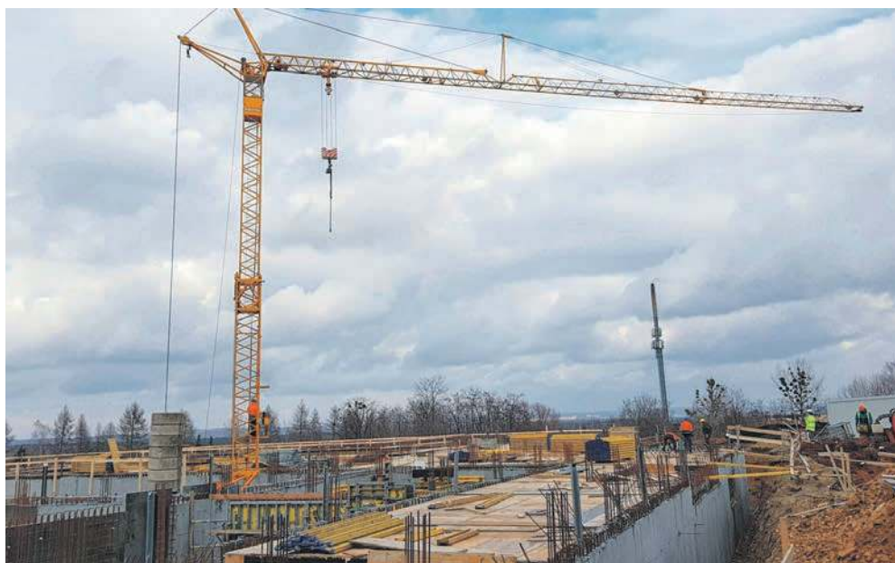
Przedsiębiorstwo „Kartel” SA jesienią ubiegłego roku wylało fundamenty, teraz rosną już mury
