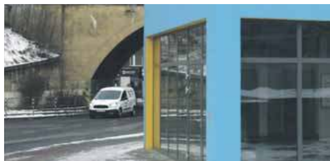
Jeden z wiaduktów do przebudowy jest przy nowym centrum przesiadkowym
