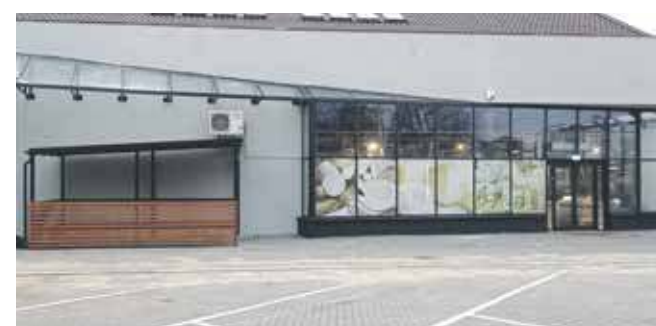
W ubiegłym tygodniu nie było jeszcze szyldu, ale trwały intensywne prace
