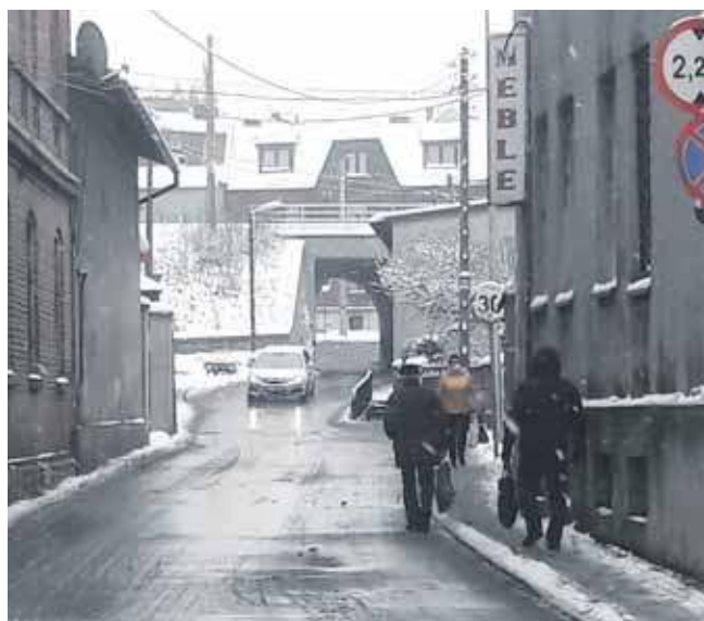
Wiadukt na ul. Zejera. Od lat mówi się o konieczności jego remontu. Już go zaplanowano. Tyle, że PKP PLK twierdzi, że uzgadnia zakres przebudowy z miastem, a miasto, że żadne rozmowy nie trwają
