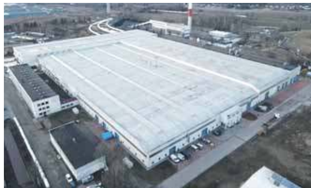
Kilka lat temu Chemet kupił Fazos. Tak wyglądają po modernizacji hale przy ul. Zagórskiej
