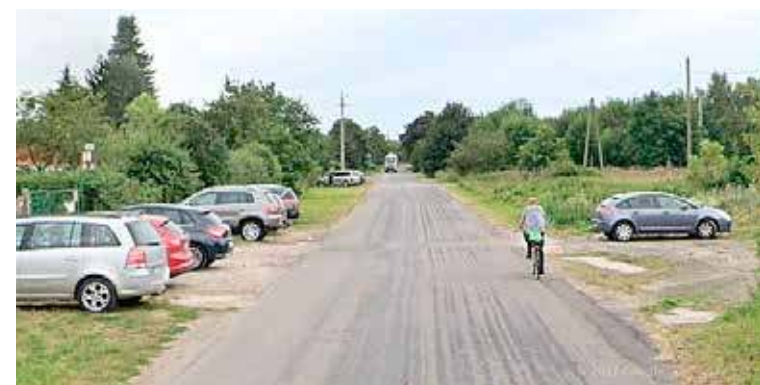
W ramach ogłoszonego przetargu wykonawca zająć się ma wykonaniem wyłącznie ścieżki rowerowej w stronę Długołęki
