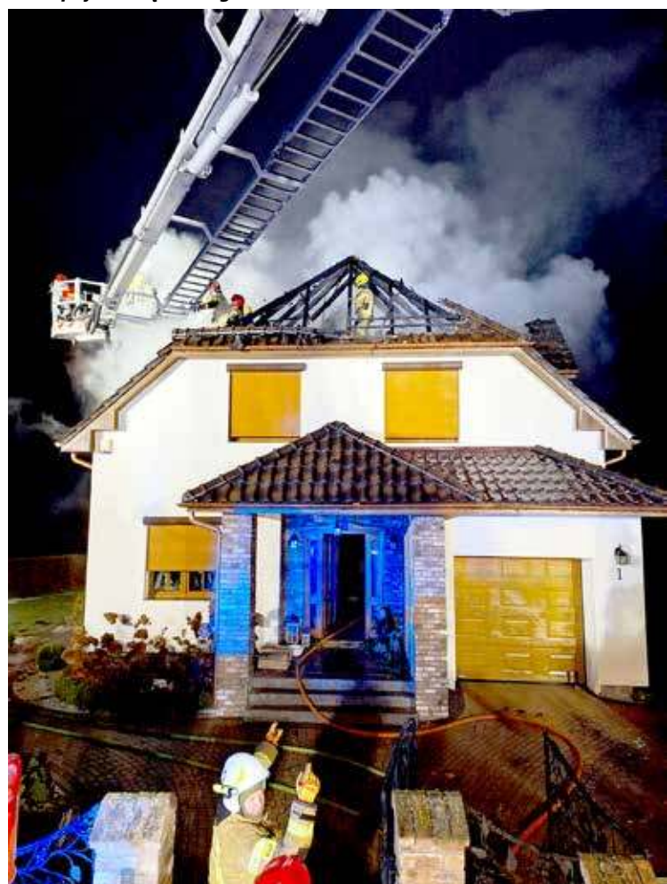
Do wygaszenia pożaru użyto m.in. podnośnika
