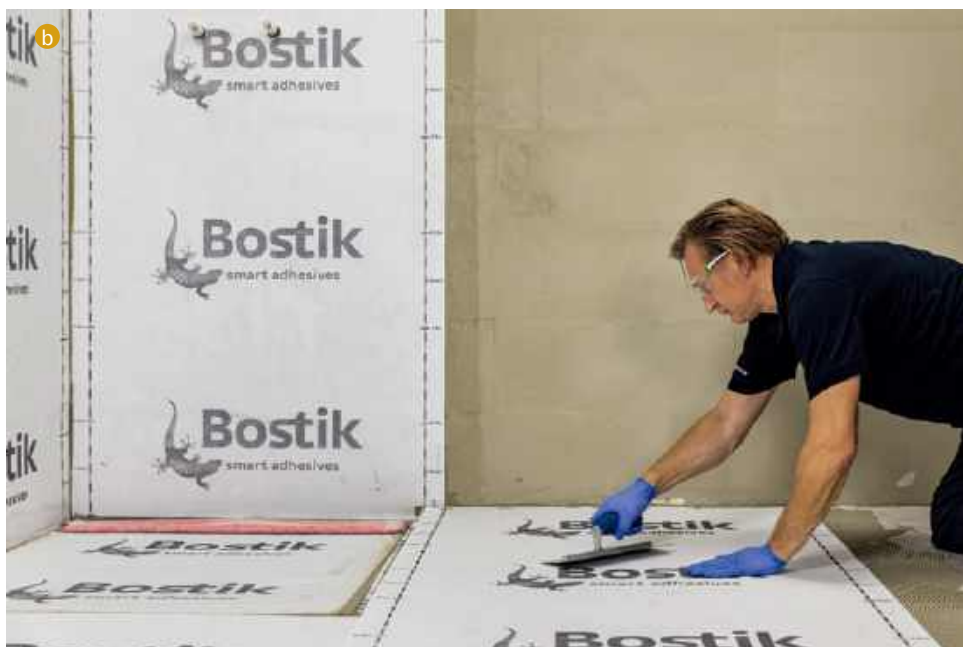
📌 Łazienkowe hydroizolacje w różnej formie – folia w płynie (a KNAUF) i membrana hydroizolacyjna (b BOSTIK).
