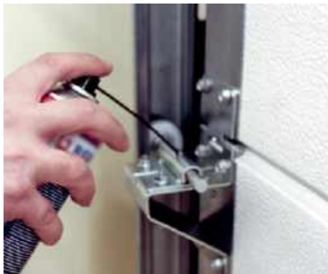
🔧 Aplikator umożliwia precyzyjne nałożenie preparatu na wszystkie mechaniczne elementy bramy. DAKO
