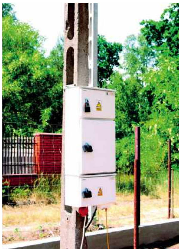
🔧 Przyłącze budowlane jest z założenia czymś tymczasowym. Niestety mając je jesteśmy rozliczani za prąd według niekorzystnej taryfy. M. BŁAŻEJEWSKI
