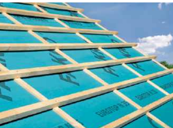
Podkład dachowy, w tym przypadku folia wstępnego krycia i ruszt z lat i kontrłat. FAKRO
