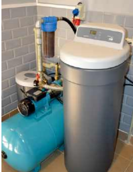
🔧 Od lewej – filtr z węglem aktywnym, mały filtr mechaniczny, zmiękcacz. L. JAMPOLSKA
