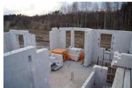
📌 Silikaty są bardzo wytrzymałe na ściskanie, co pozwala na projektowanie z nich ścian konstrukcyjnych o grubości 18 cm. H+H
