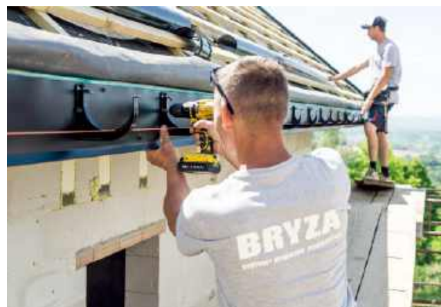
🔧 Haki, na których wiesz się rynny, muszą być zamontowane w odstępach co najmniej 50–60 cm. CELLFAST
