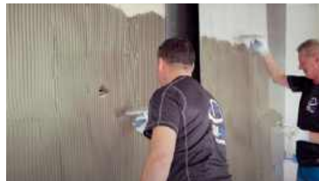
🔧 Klejąc płytki XXL klej nakłada się na nie i na podłogę. KNAUF
