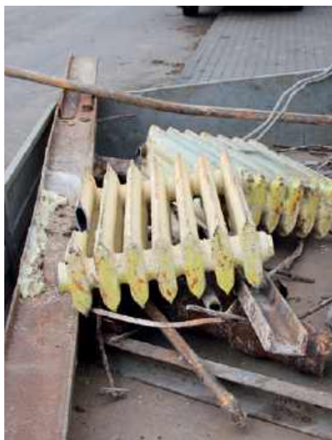
🔗 Odpady metalowe wyselekcjonowane z rozbiórki. J. WERNER
