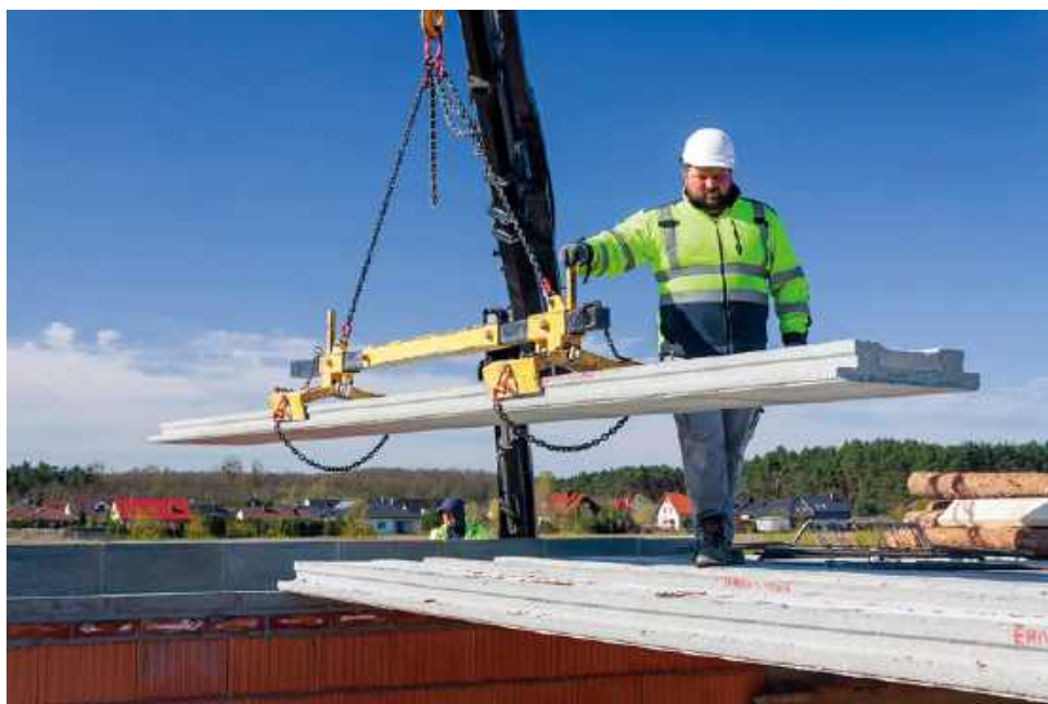
🔧 Do układania lżejszych stropów prefabrykowanych wystarczy HDS, czyli samochód ciężarowy z żurawiem. STROPY.PL
