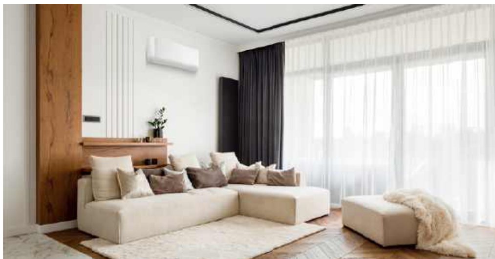
🔑 Najlepiej, gdy klimatyzator zamontowany jest na środku pomieszczenia. Pozwoli to zapewnić równomierny rozkład wydobywającego się z niego powietrza. ROTENSO
