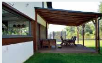
❷ Zadaszenie wsparto na drewnianych słupach, na dachu ułożono deski i gont bitumiczny.
