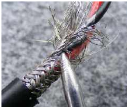
Rysunek 13. Pleciony kabel ekranowany jest najlepszy, ale wymaga pracochłonnego rozczesywania, aby umożliwić jego prawidłowe skręcenie i lutowanie
