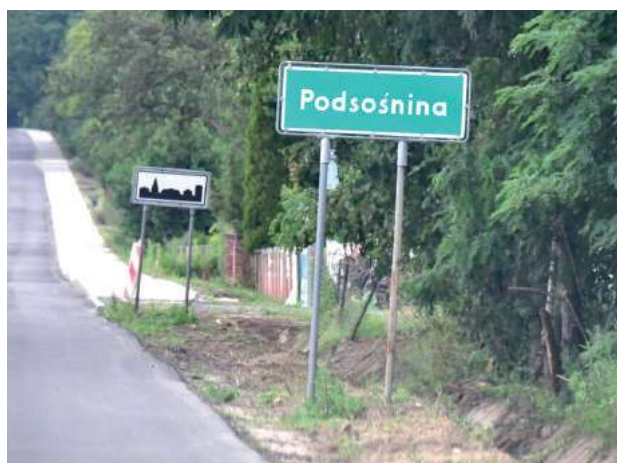
Planowany termin zakończenia inwestycji przebudowy drogi Podsośnina Łukowska - Tarnogród to 23 października 2023 roku
