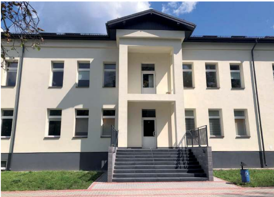
Wyremontowany budynek oddziału zakaźnego biłgorajskiego szpitala
