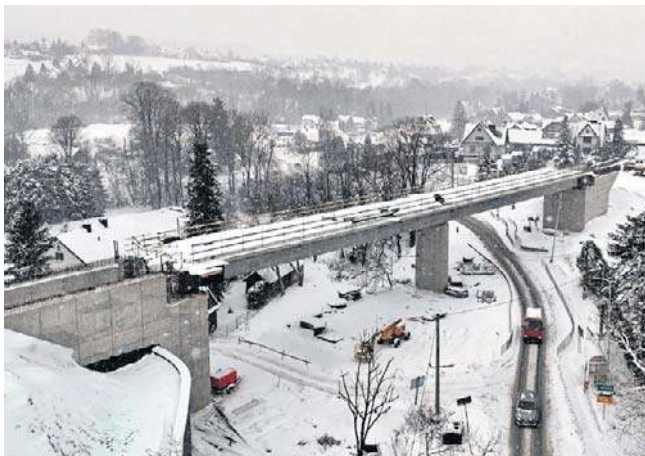
Prace są realizowane także w obrębie ul. Matki Boskiej Bolesnej - tam powstaje nowy most kolejowy
