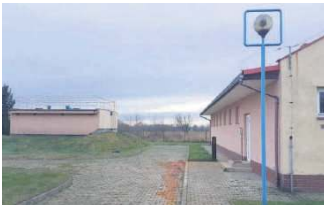
W minionym tygodniu awarii uległa pompa w stacji uzdatniania wody w Krzywiniu
