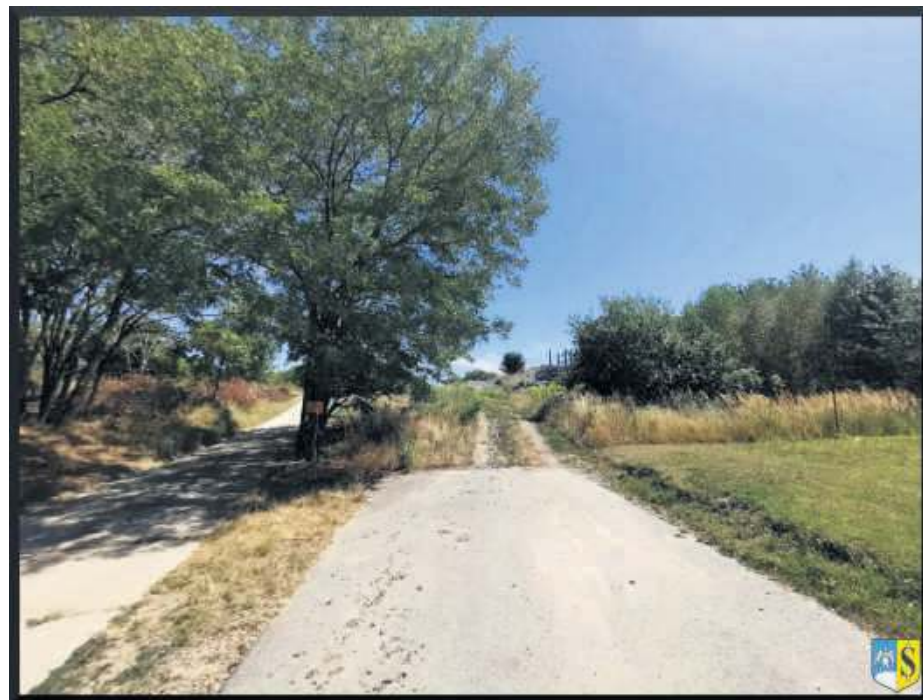
Droga na ulicy Wichrowej w Strzelinie zostanie wytyczona na wprost od miejsca, gdzie obecnie kończy się nawierzchnia asfaltowa. Fot. UMiG Strzelin
