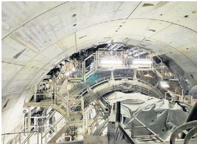
Na S19 między Rzeszowem Południe a Babicą powstało dotychczas 500 pierścieni obudowy tunelu
