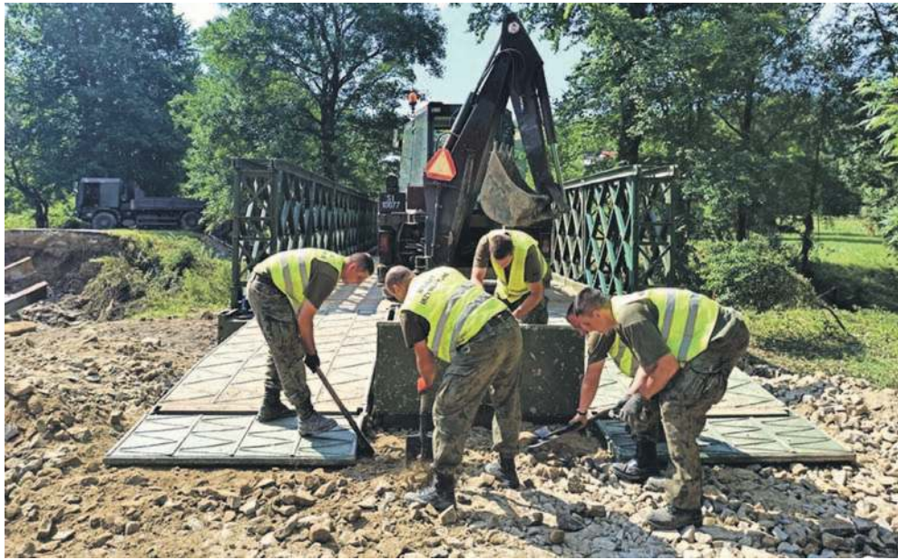
Żołnierze 3. Batalionu Inżynieryjnego z Niska w ciągu zaledwie dwóch dni zbudowali most tymczasowy w Hadlach Szklarskich
