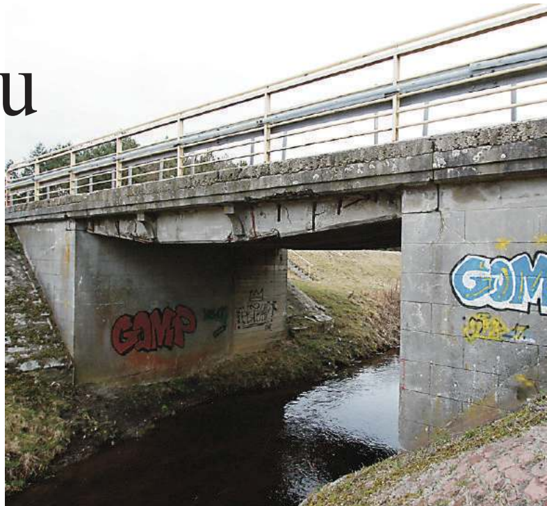
Według wstępnych planów PZDW, obecna przeprawa ma być zastąpiona nowym mostem
