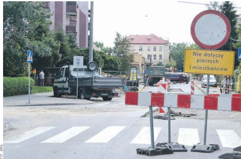
Remont ulicy Słowackiego obejmuje m.in. wymianę nawierzchni od skrzyżowania z ulicą Kwiatkowskiego do PSP nr 1
