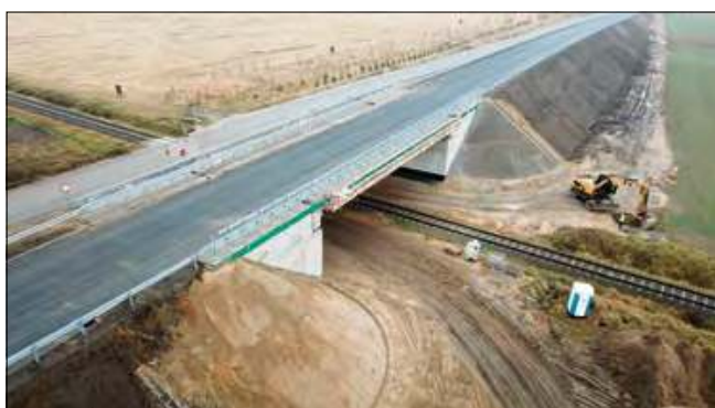
Pierwsi kierowcy przejechali po nim w poniedziałek, 20 stycznia.
