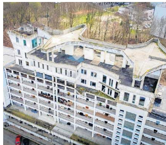
Część nadbudowy została już rozebrana
