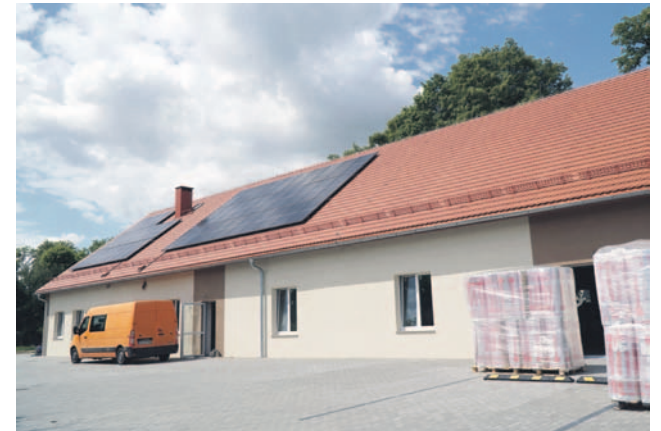
Świetlica w Jazkowicach
