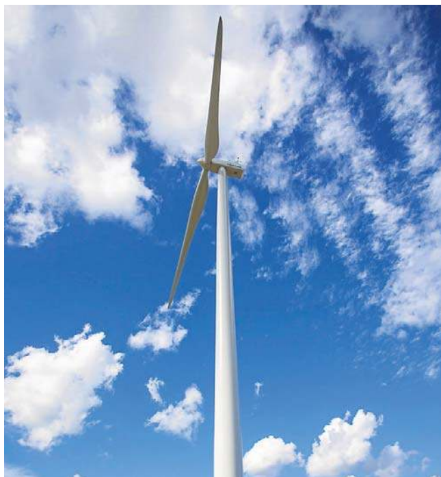
Nowoczesne turbiny mają wysokość 270 metrów i są widoczne z wielu kilometrów
