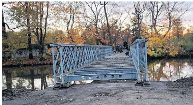
Elementy konstrukcji składanego mostu drogowego przekazała Rządowa Agencja Rezerw Strategicznych
