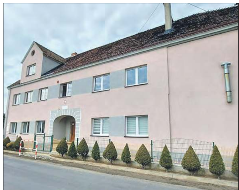
Obiekt Szkoły Podstawowej w Straduni
