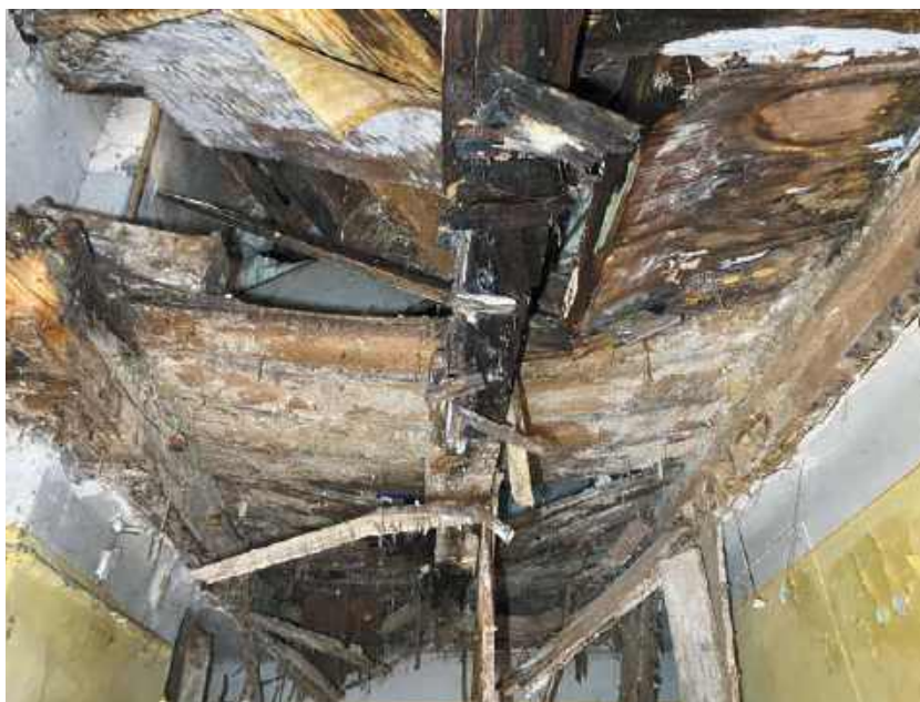
FOT. 1 Wymiana drewnianego stropu, który uległ awarii w wyniku działania strocza domowego, przez co stracił zarówno właściwości użytkowe, jak i konstrukcyjne, nie podlega dyskusji; fot.: autor
