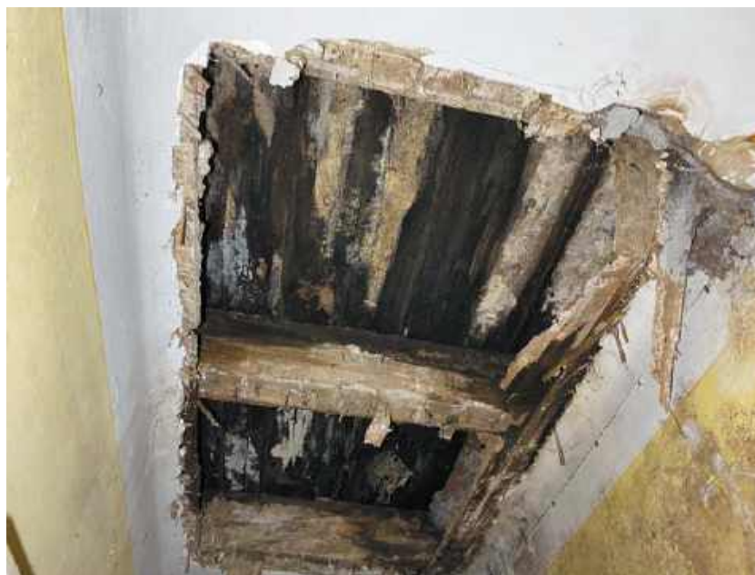
FOT. 2 Porażenie stropu drewnianego grzybem domowym niewidoczne do czasu odstonięcia konstrukcji; fot.: autor
