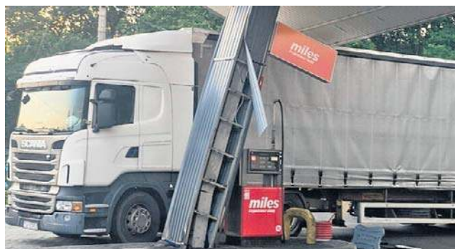
Uszkodzona stacja paliw w Wierchowisku
